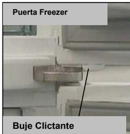
En la parte inferior de las Puertas del Refrigerador y del Freezer se utilizan los bujes clictantes que ayudan al cierre de las mismas. Estos bujes evitan que las Puertas queden parcialmente abiertas.
